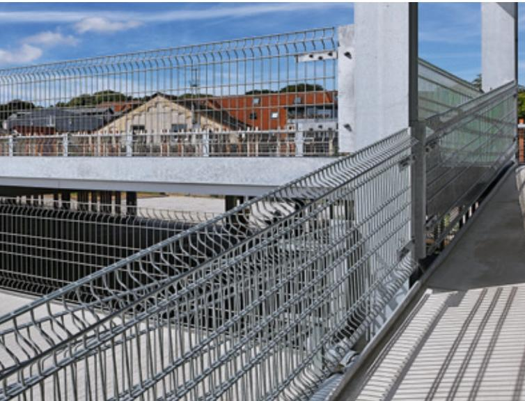
Systembefestigungen zur Schraubmontage dienen der Lastableitung von PKW-Anpralllasten gemäß DIN EN 1991-1-7 sowie eines Holm-drucks von 1,0 kN/m in die bauseitige, gemäß statischen Erforder-nissen dimensionierte Stahlkonstruktion. Die Befestigungen verfügen über Ausgleichsmöglichkeiten von Toleranzen.
