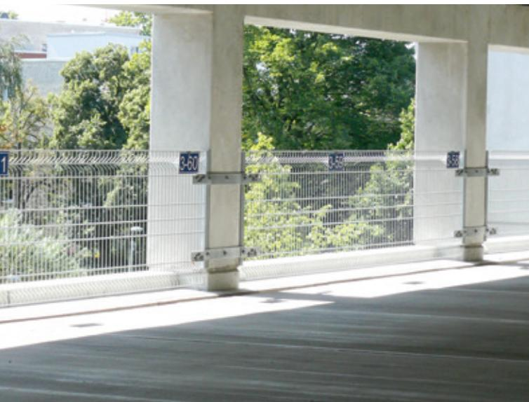
Abhängig von der Geometrie der Tragkonstruktion, sind für die Befestigung der INTEGRA-pw an den Betonstützen zusätzliche, bauseitige Anschlussvorbereitungen erforderlich, an denen die Systembefestigungen verschraubt werden. Gerne unterstützen wir Sie bei der Kon-zeption und Planung durch die Bereitstellung von Datenblättern und Bemessungsdiagrammen für eine statische Berechnung.
